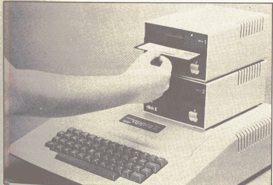
Fig. 2.3. — Insertion d'une disquette dans l'unité « Disk II ».
